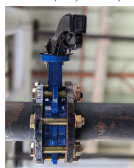
Příklad motýlkového ventilu v instalaci průmyslové vody
